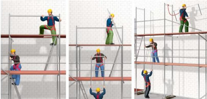
Bilder 5 - 7: Montageablauf bei Gerüstmontage mit MSG und PSAgA
