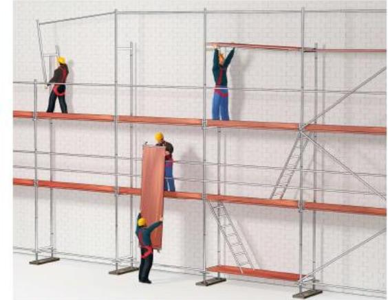
Bild 2: Montage: systembedingt vorlaufendes Geländer
