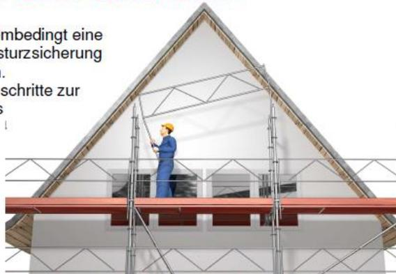
Bild 1: Montage: systembedingt vorlaufendes Geländer
