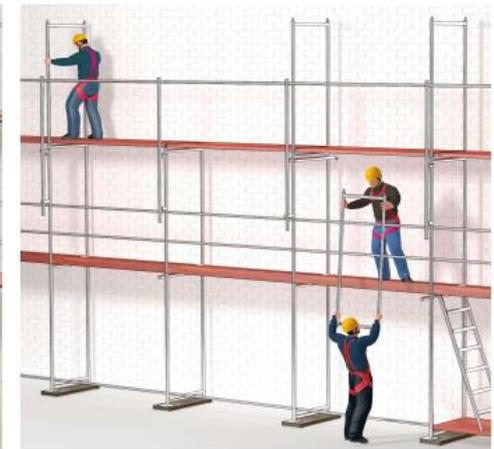
Bild 4: Montage im Schutz des MSG
